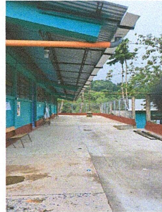
Foto 2: MEJORAMIENTO DE CANALES Y CAIDAS DE AGUA PLUVIAL
