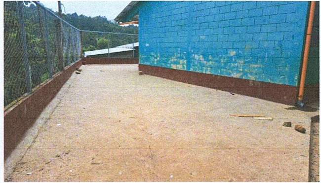
Foto 2: MEJORAMIENTO DE ZOCALO CON PINTURA COLOR ROJO OXIDO
