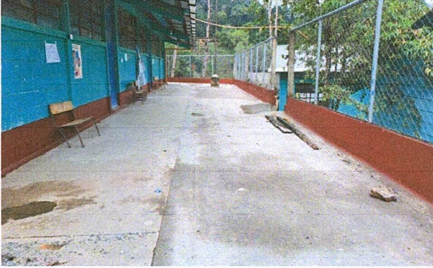
Foto 1: MEJORAMIENTO DE ZOCALO CON PINTURA COLOR ROJO OXIDO
