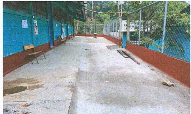
Foto 4: MEJORAMIENTO DE ZOCALO CON PINTURA COLOR ROJO OXIDO
